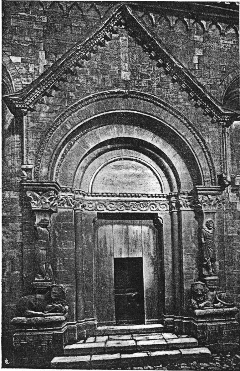
Fig. 8. - Porta sul lato di mezzogiorno
