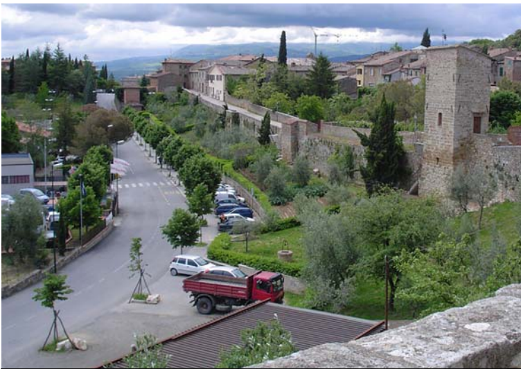
Fig. 5.15 Veduta delle mura di cinta che affacciano su via dei Fossi.
