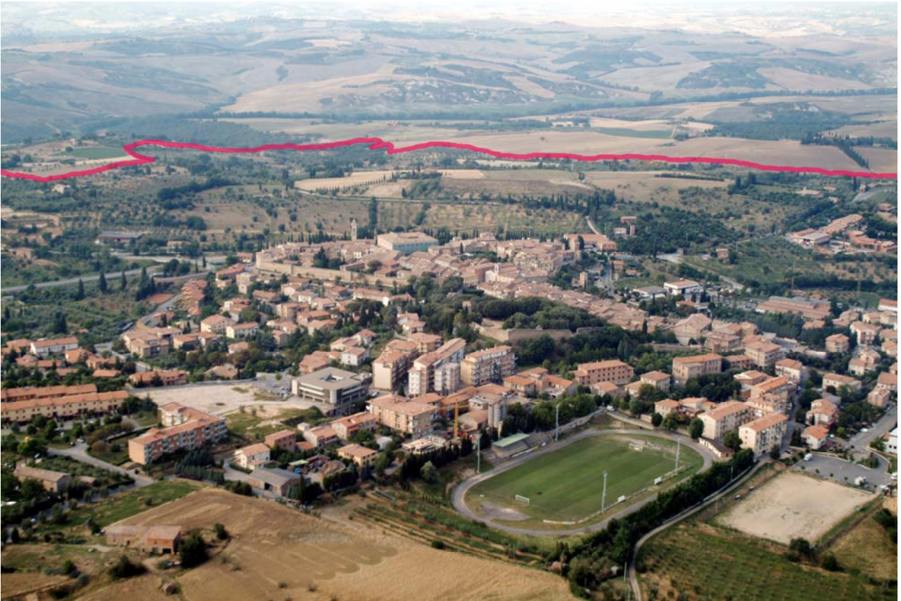
Fig. 5.23 Veduta da terra del settore est di San Quirico d'Orcia
