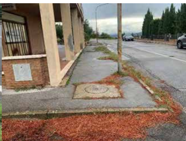
Foto 4 - scalini trasversali, tombini non a livello
