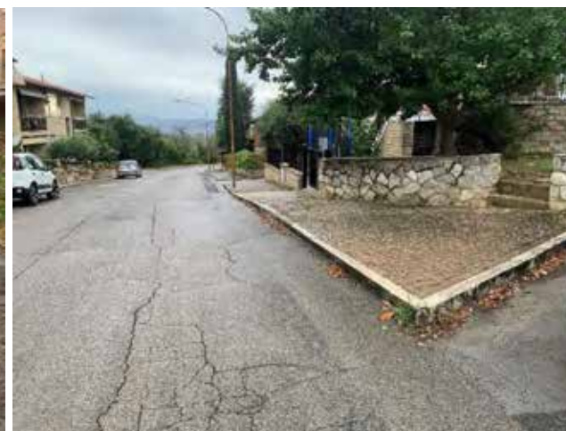
Foto 6 - scalini trasversali, tombini non a livello
