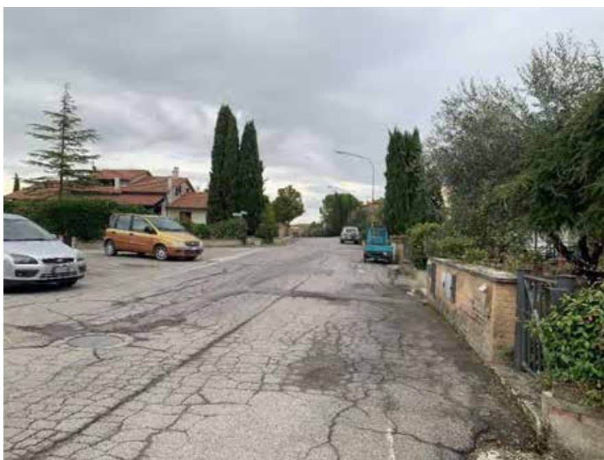
Foto 1 – larghezza non adeguata
