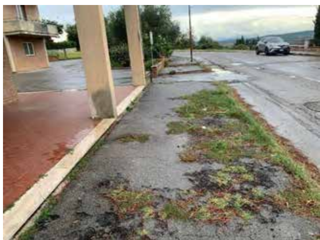
Foto 5 – pavimentazione sconnessa
