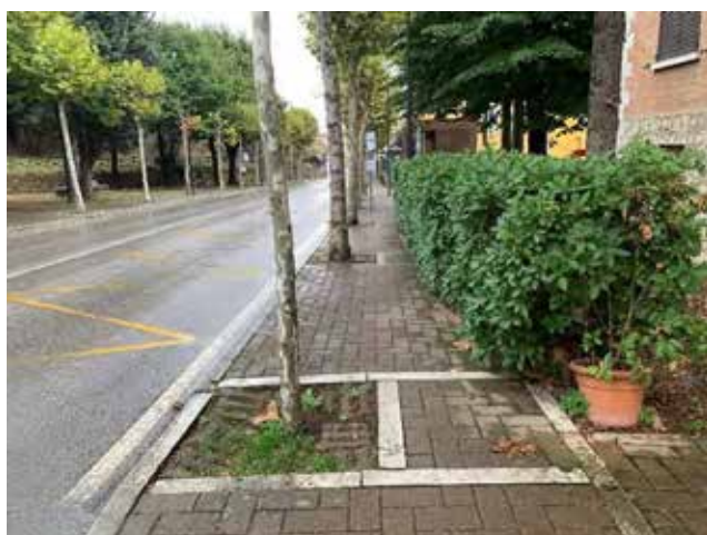
Foto 3 - palo illuminazione (ostacolo), tombino (disconnessione)
