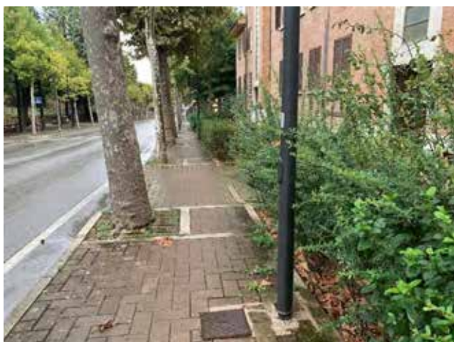
Foto 3 - palo illuminazione (ostacolo), tombino (disconnessione)
