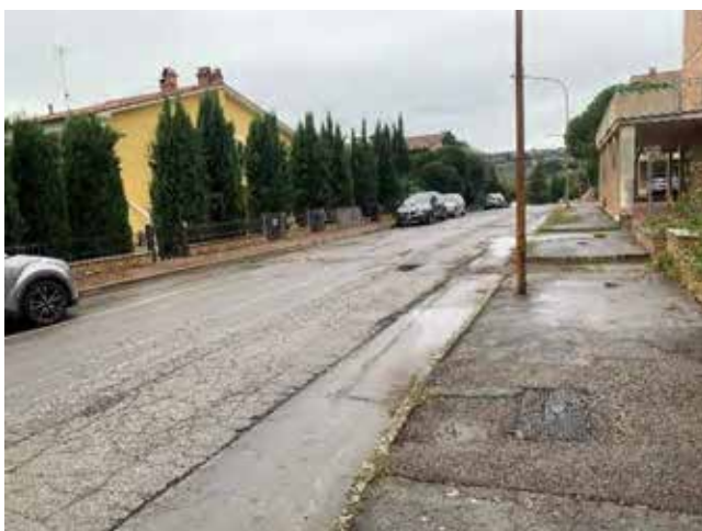
Foto 5 – pavimentazione sconnessa
