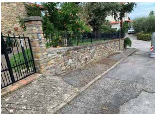
Foto 1 – pavimentazione sconnessa
