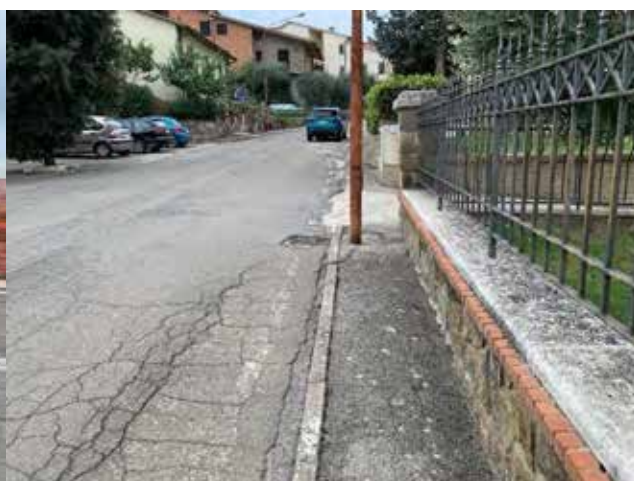
Foto 2 – larghezza inadeguata, pavimentazione sconnessa, presenza di ostacoli
