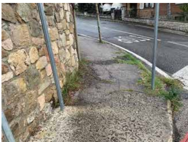
Foto 1 – pavimentazione sconnessa
