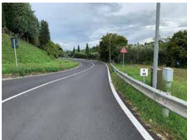
Foto 1 Assenza di marciapiede o "marciapiede virtuale"
