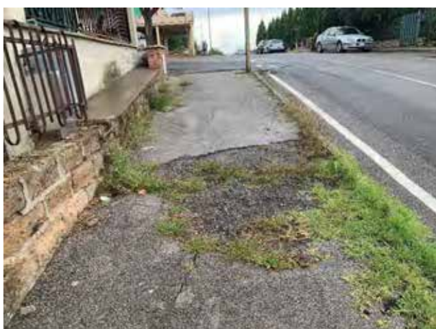
Foto 3 – pavimentazione sconnessa
