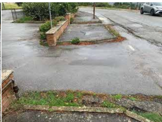
Foto 6 - scalini trasversali, tombini non a livello
