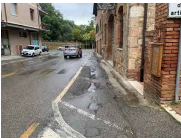
Foto 3 – pavimentazione sconnessa
