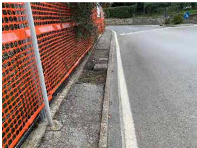
Foto 1 – pavimentazione sconnessa dimensioni marciapiede inadeguato Foto 2 – assenza di marciapiede
