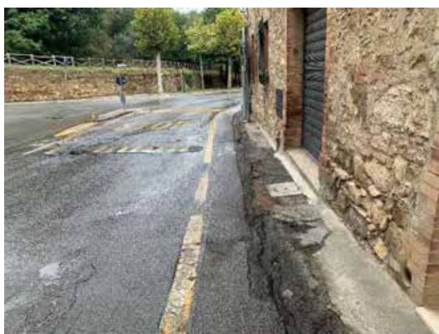
Foto 4 - pavimentazione sconnessa
