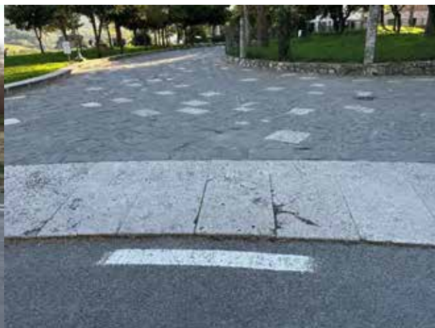
Foto 2 – Rampa da adeguare
