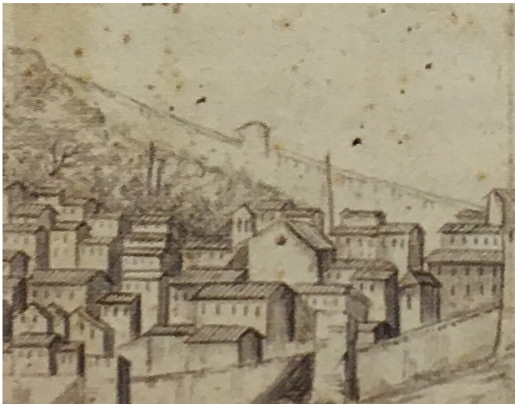
Fig.8 - Anonimo, veduta di San Quirico d'Orcia, particolare, BCS, ms E15, nella quale si vede la disposizione interna degli Horti.
