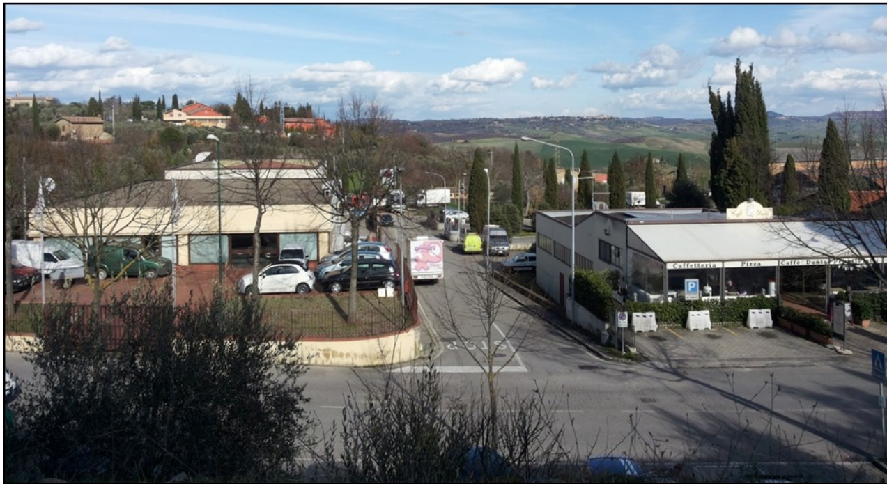
Foto 2: Veduta di Via Etruria dalla mura. I due capannoni da sostituire sulla sinistra
