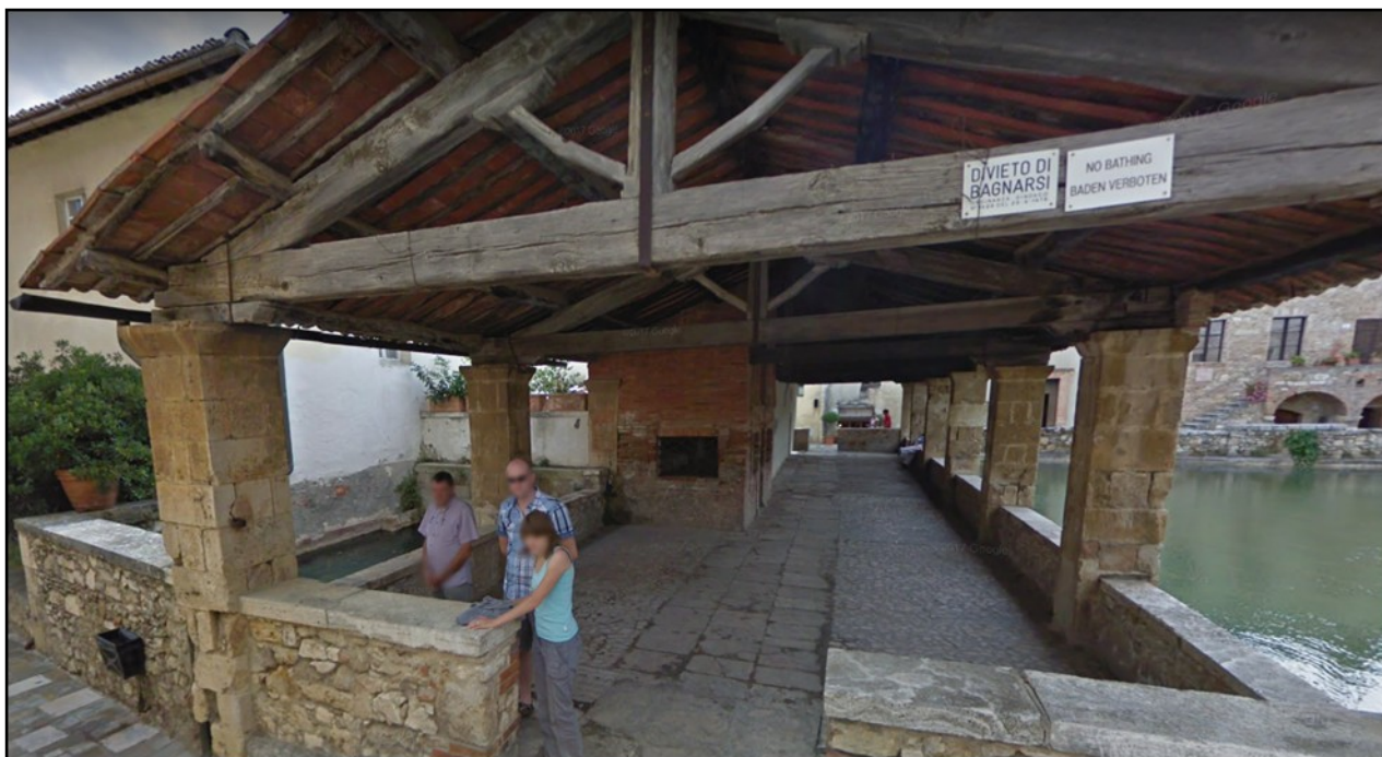
Foto 3. La loggia di Santa Caterina
