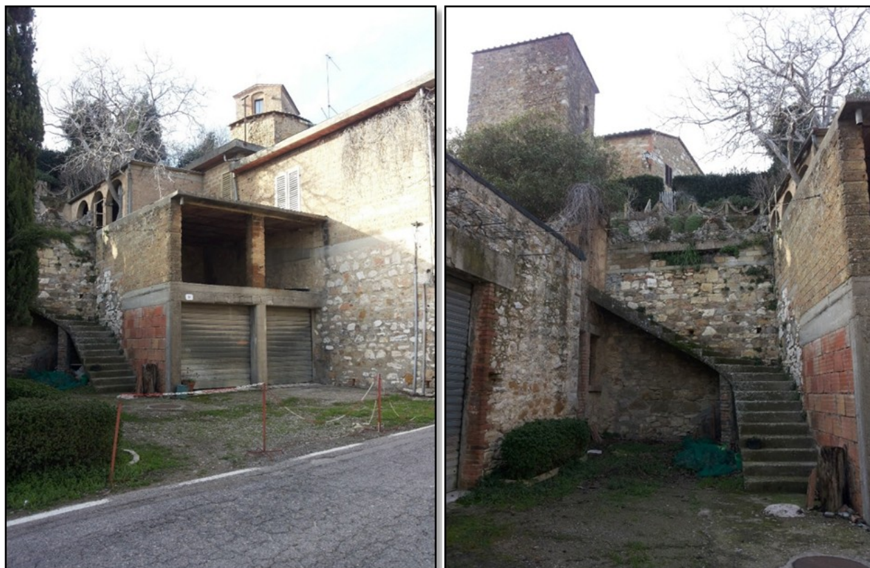
Foto 2: edificio da abbattere
