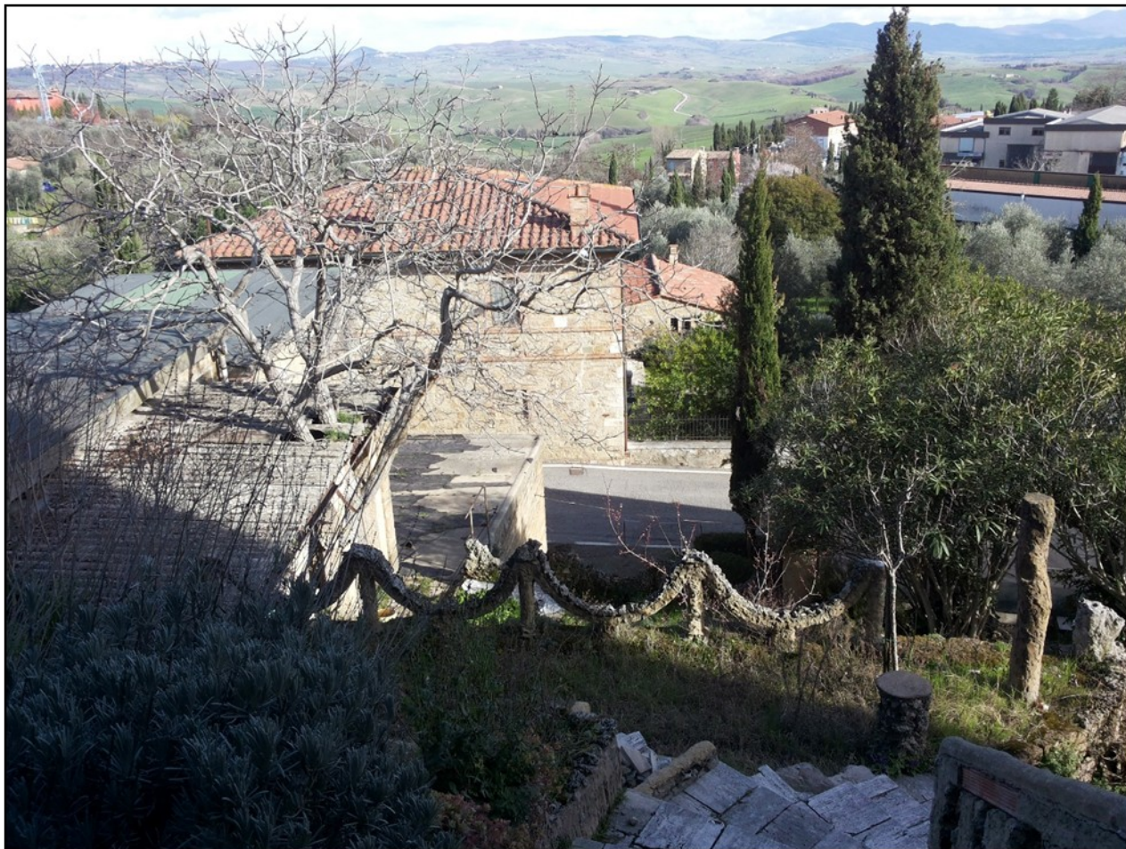
Foto 3: Attuale discesa pedonale privata ai locali in oggetto, da riprogettare e rendere accessibile al pubblico
