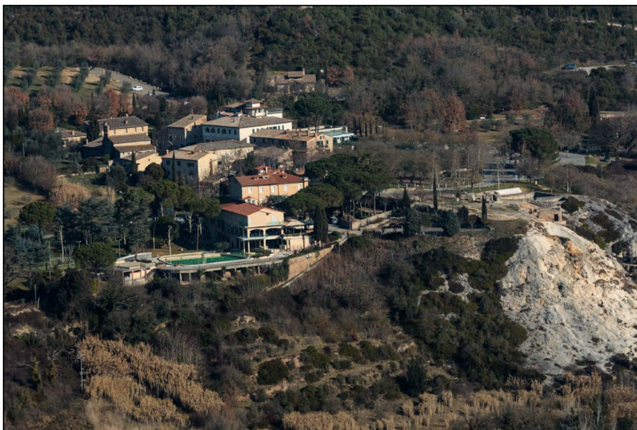
Foto 1: Veduta del lato sud
