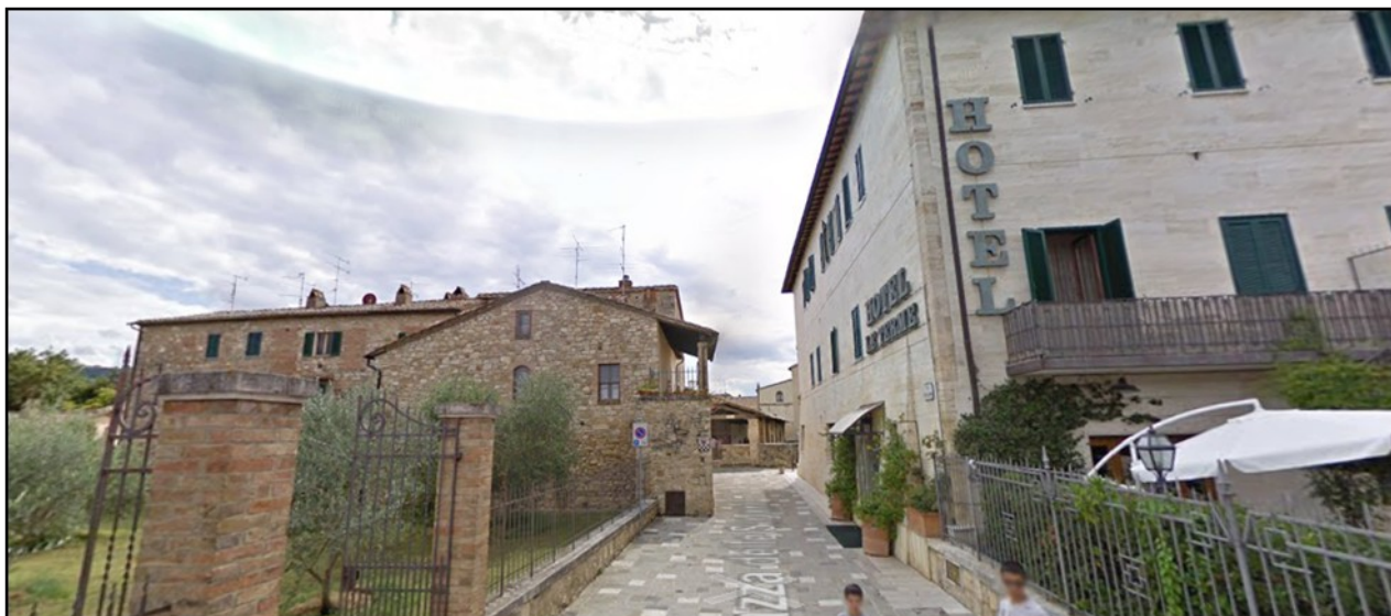
Foto 2: Vicolo sotto il quale è previsto il tunnel di collegamento tra l'hotel e l'edificio limitrofo
