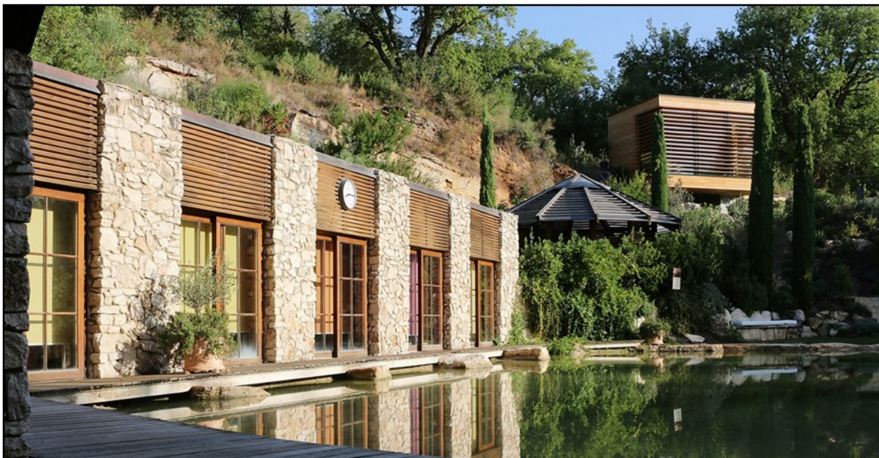
Foto 1: Zona di localizzazione dei nuovi volumi fuoriterra
